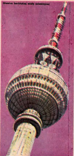
Głowica berlińskiej wieży telewizyjnej
